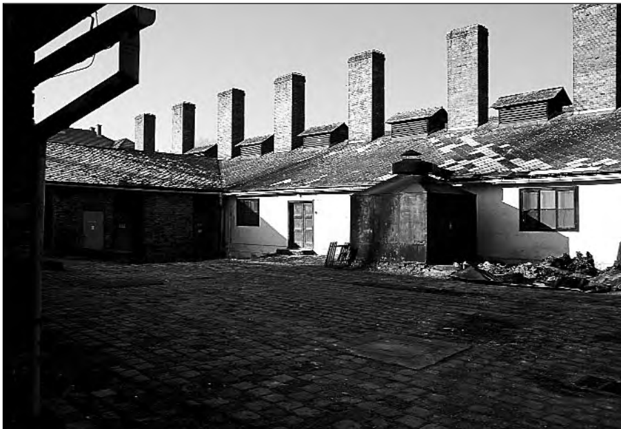
Die ehemalige Lagerküche soll für Museumszwecke instandgesetzt werden.
