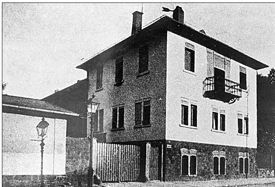
Die ehemalige „Perlenfabrik“, Ginnheimer Landstraße 40 - 42, in Frankfurt/Main.
