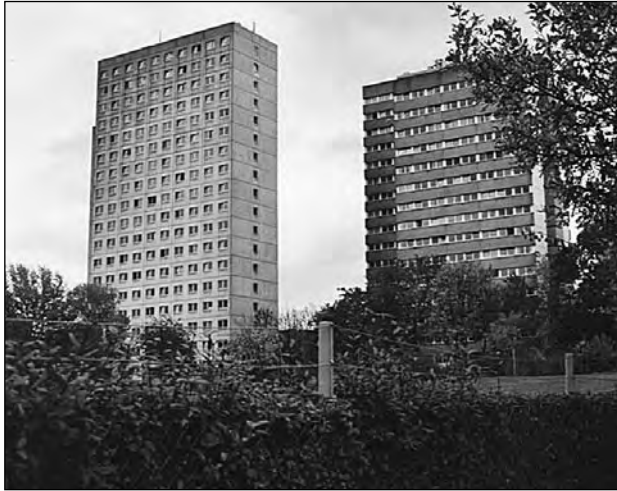
Auf dem Grundstück der ehemaligen „Perlenfabrik“ stehen heute Studentenwohnheime der Universität Frankfurt .
