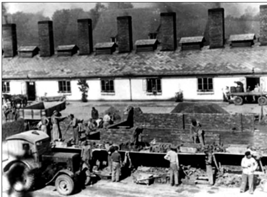
Historische Aufnahme vom Bau der Lagerküche in Auschwitz I.
