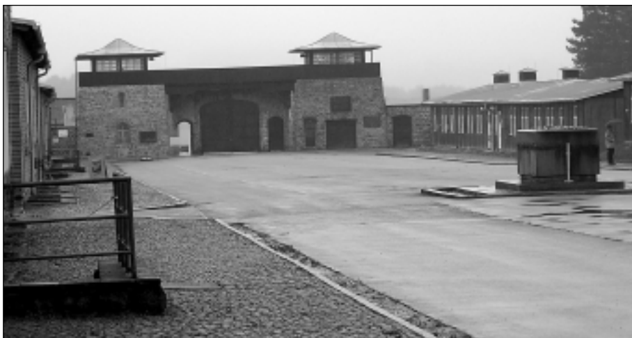
Blick vom Innenhof des Konzentrationslagers Mauthausen auf das Eingangsgebäude
