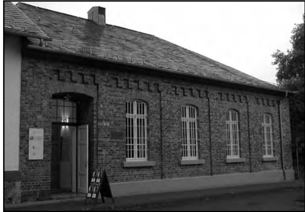
Das neue Kulturzentrum in Lich
