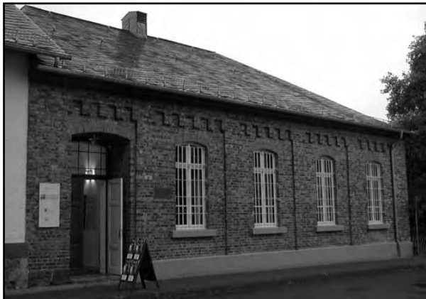
Das neue Kulturzentrum in Lich
